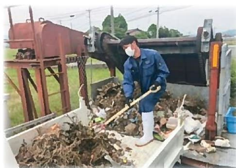
水路のゴミ除去作業の様子
